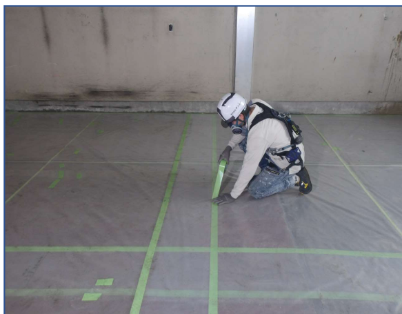
工場棟アスベスト養生作業
