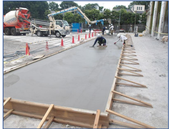
テント基礎工事
