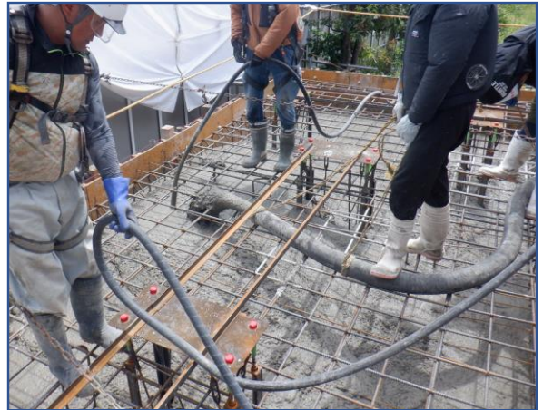
テント基礎工事
