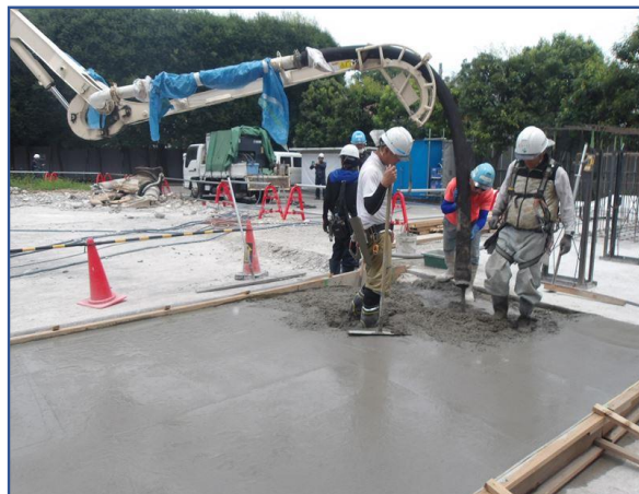
テント基礎工事
