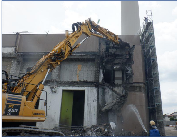
工場棟躯体解体
