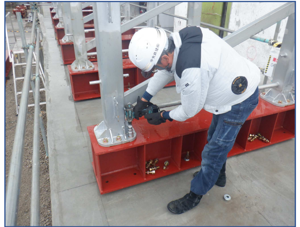
全覆い仮設テント組立て工事
