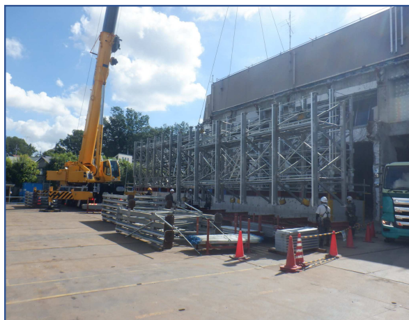
全覆い仮設テント組立て工事
