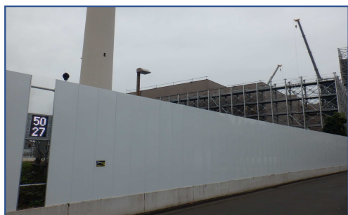
定点撮影(南側)
