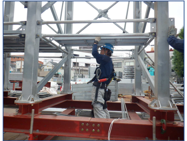
全覆い仮設テント組立て工事
