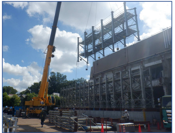
全覆い仮設テント組立て工事
