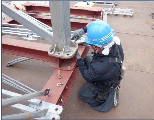
全覆い仮設テント組立て工事
