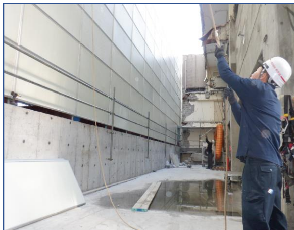
全覆い仮設テント組立て工事
