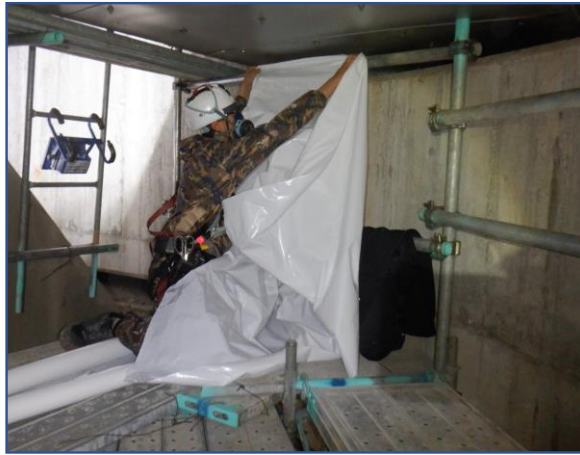
RCF養生工事
