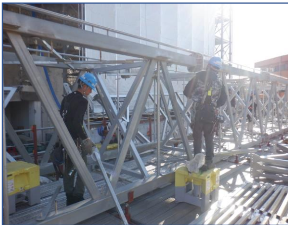
全覆い仮設テント組立て工事
