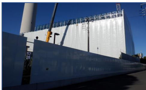
定点撮影(南側)
