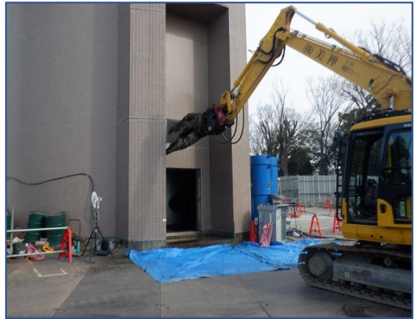
煙突内筒解体工事
