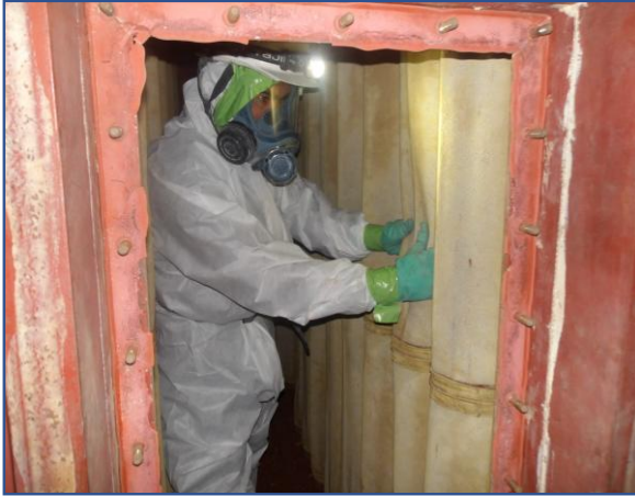
工場棟 除染作業
