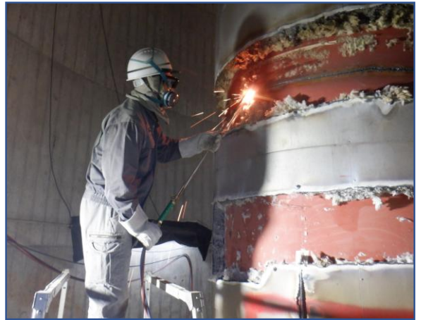
内筒解体作業
