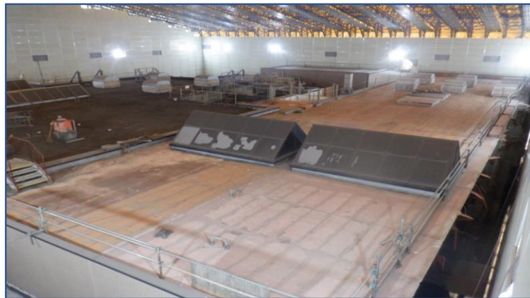
テント内定点撮影(北西側)
