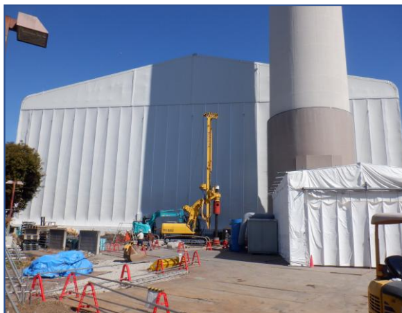
敷地内定点撮影(南西側)
