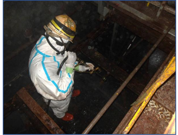
工場棟 除染作業
