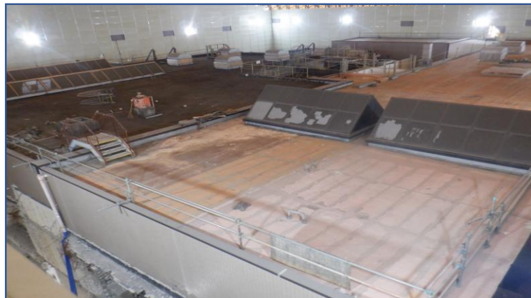
テント内定点撮影(北西側)
