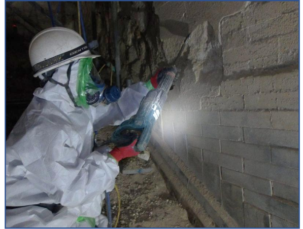
工場棟 除染作業
