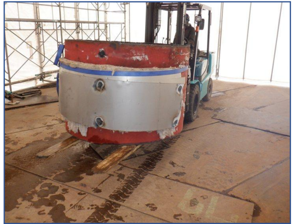
内筒解体作業
