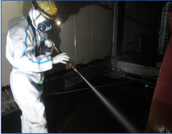
工場棟 除染作業
