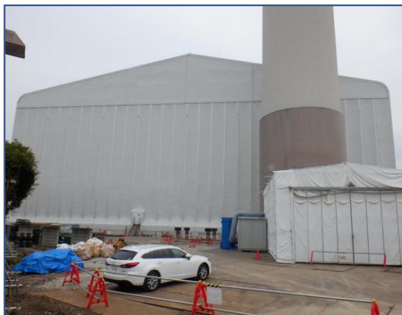
敷地内定点撮影(南西側)
