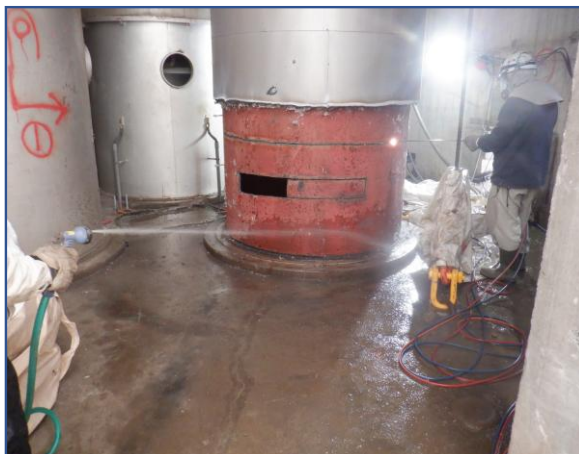
内筒解体作業
