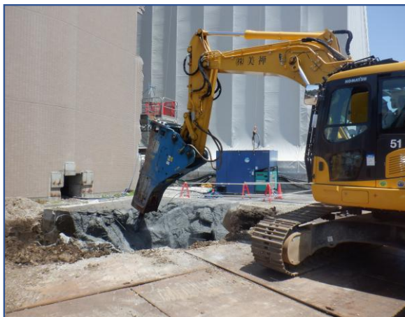
仮設基礎コンクリート解体作業
