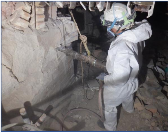
工場棟 焼却炉内耐火物撤去作業
