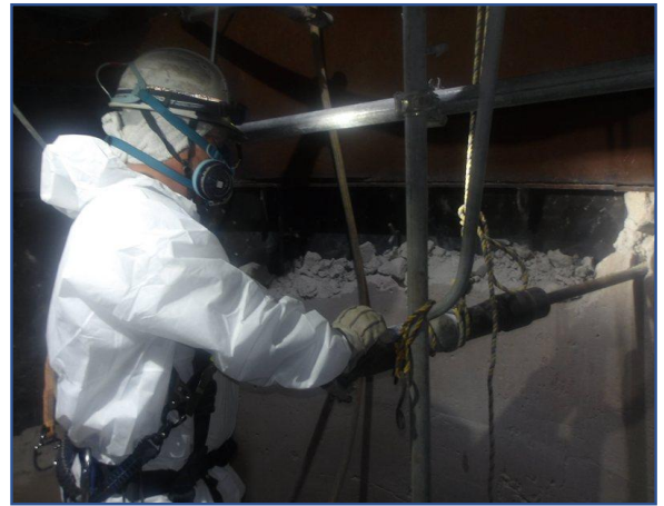
工場棟 焼却炉内耐火物撤去作業
