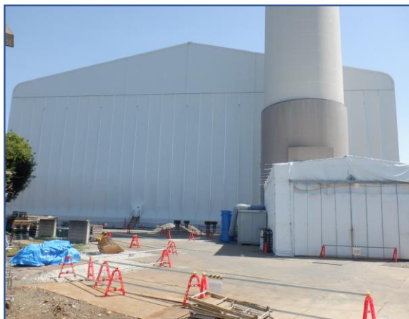
敷地内定点撮影(南西側)
