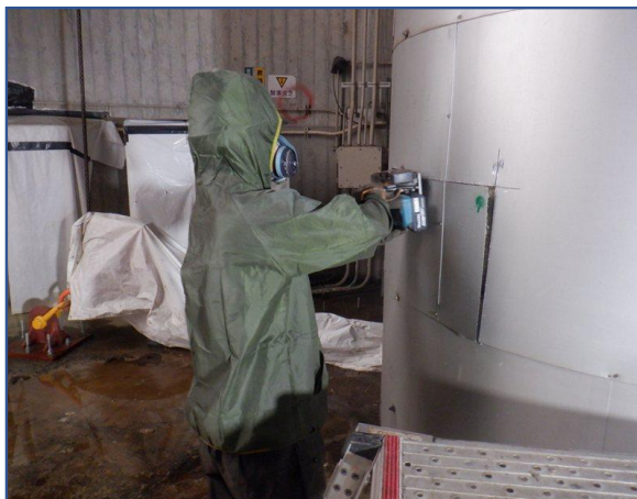
内筒解体作業
