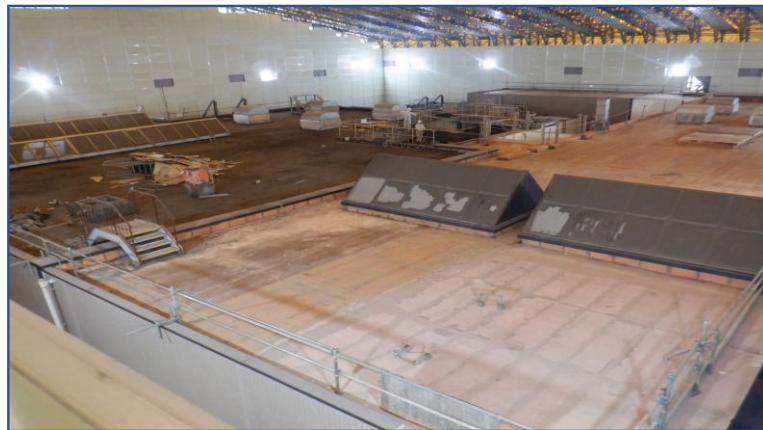
テント内定点撮影(北西側)
