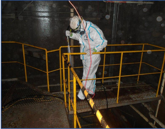
工場棟 除染作業
