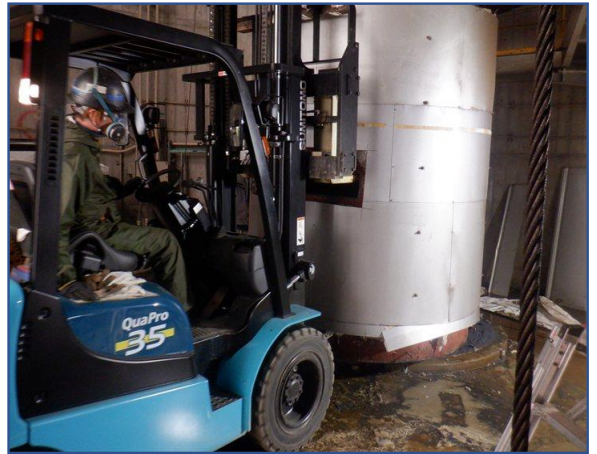
内筒解体作業
