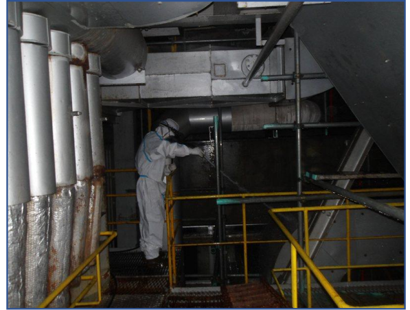
工場棟 除染作業
