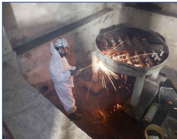
工場棟 設備撤去作業
