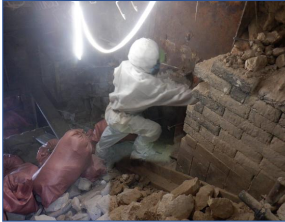
工場棟 焼却炉内耐火物撤去作業
