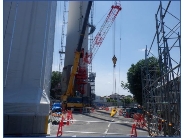
タワークレーン組立て作業
