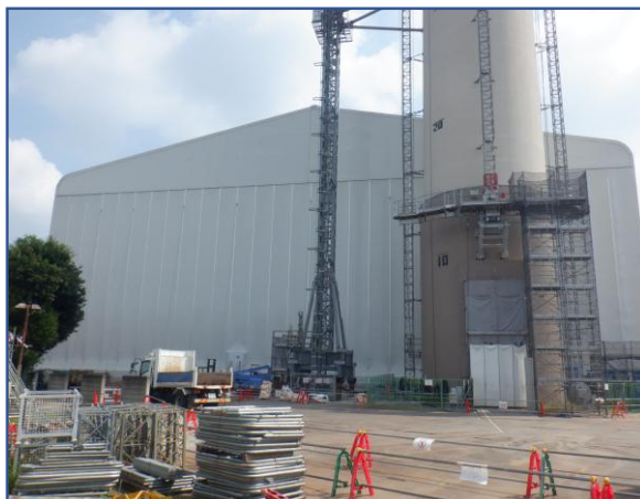
敷地内定点撮影(南西側)
