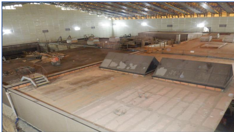
テント内定点撮影(北西側)
