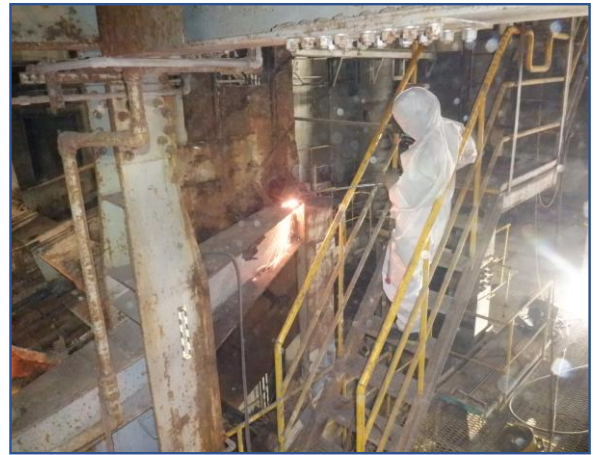
工場棟 設備解体
