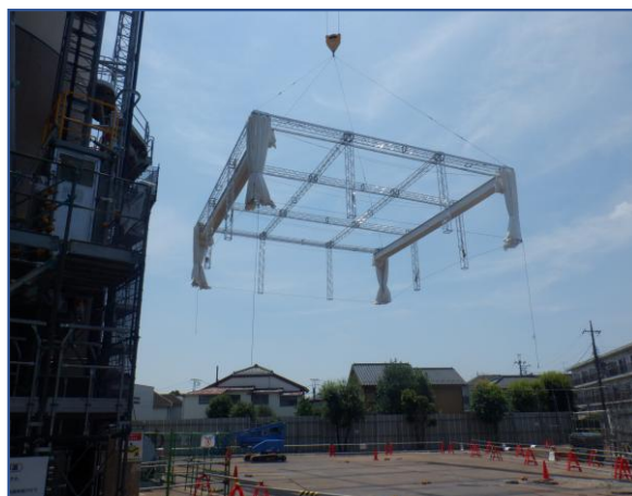
煙突 ケージシステム組立
