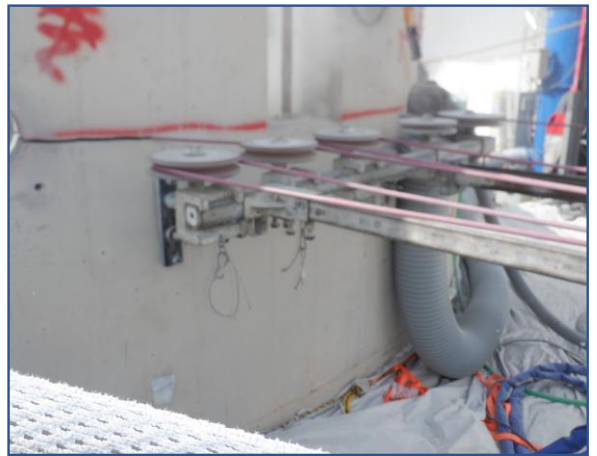
煙突 外筒撤去
