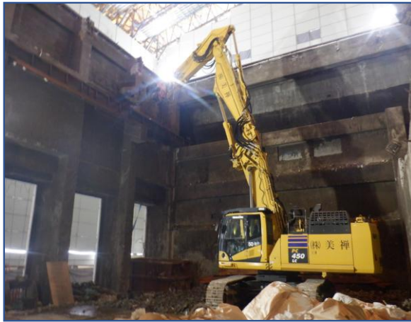
工場棟 躯体解体
