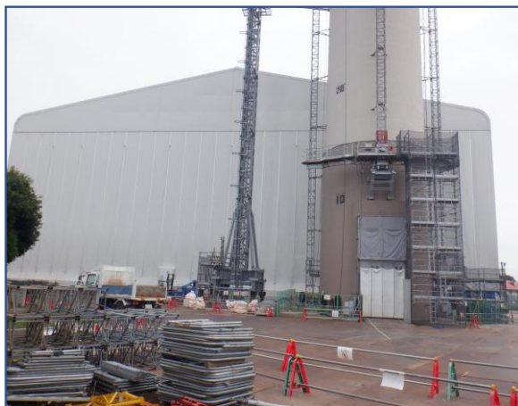
敷地内定点撮影(南西側)
