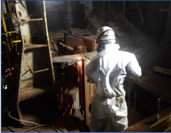
工場棟 設備解体
