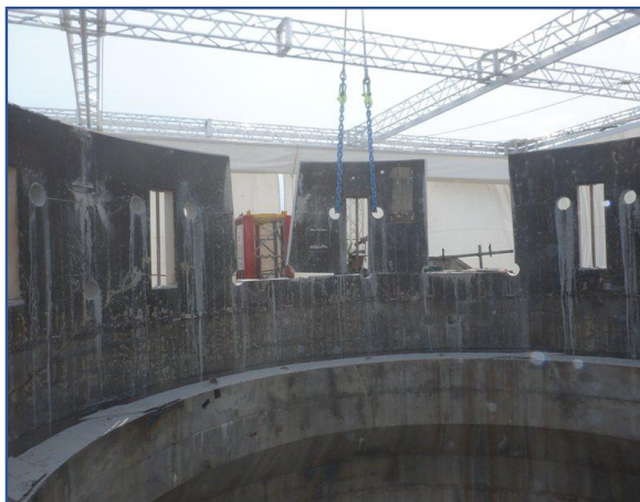
煙突 外筒撤去
