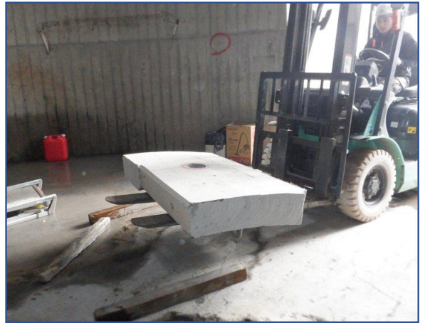
煙突 外筒撤去
