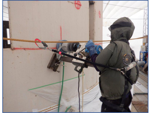
煙突 外筒撤去
