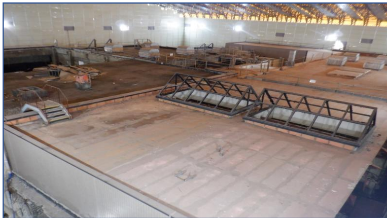
テント内定点撮影(北西側)
