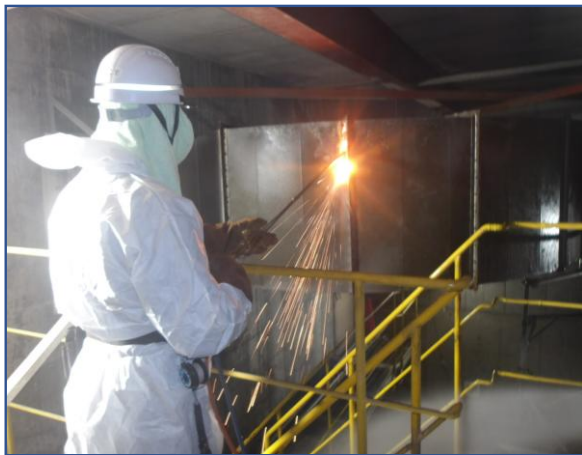
工場棟 設備解体
