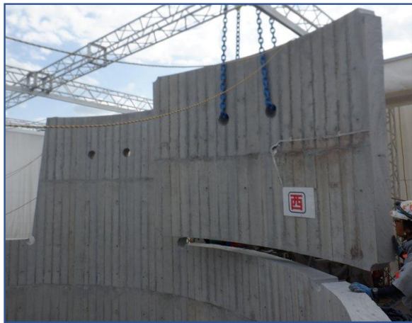
煙突 外筒撤去
