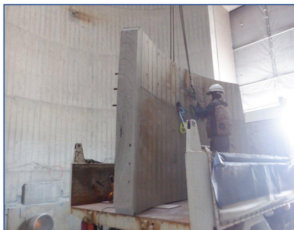
煙突 外筒撤去
