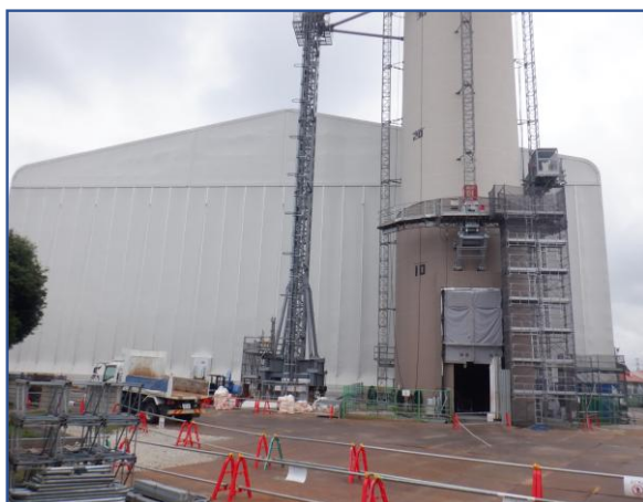
敷地内定点撮影(南西側)
