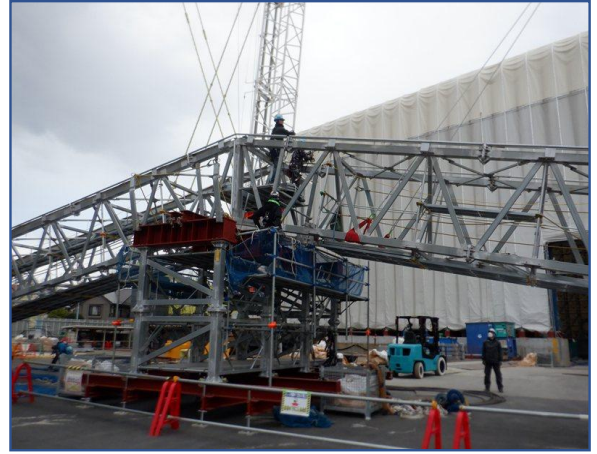
全覆い仮設テント解体
