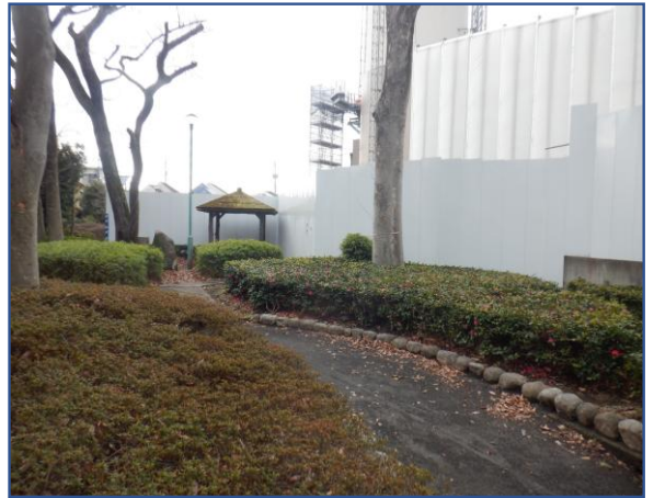
土壌汚染対策工事に伴う仮囲い移設
