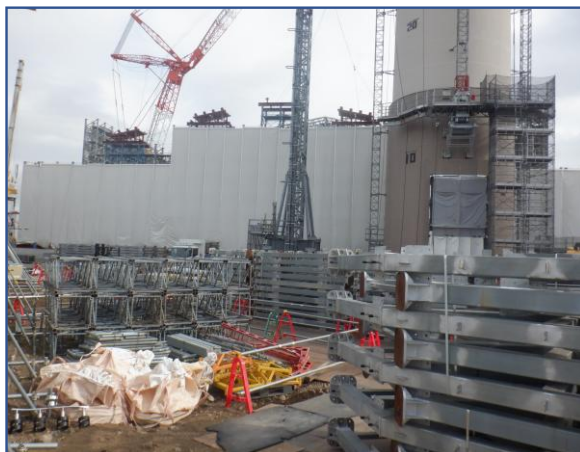
敷地内定点撮影(南西側)
