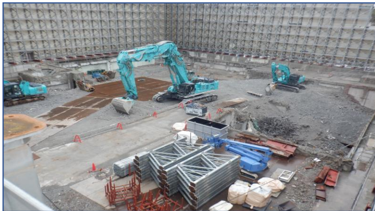
テント内定点撮影(北西側)
