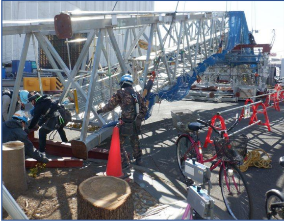
全覆い仮設テント解体
