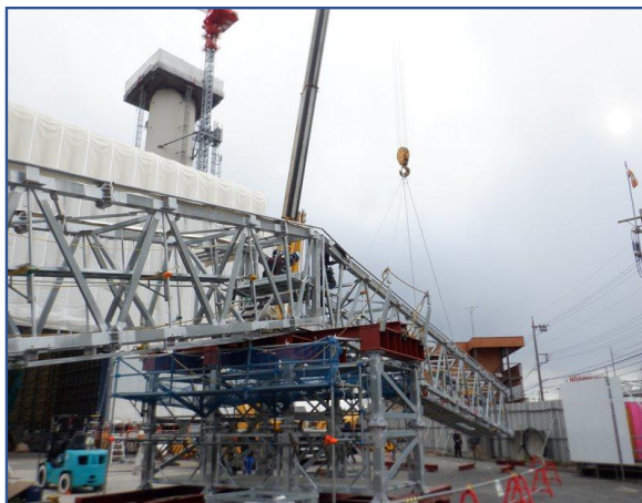
全覆い仮設テント解体
