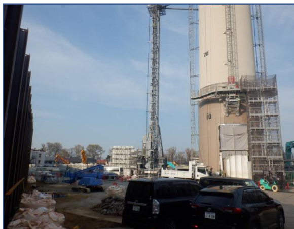
敷地内定点撮影(南西側)
