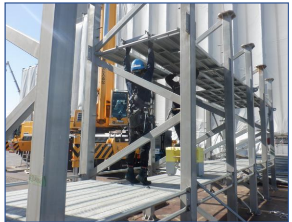
全覆い仮設テント解体
