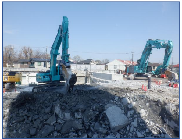
全覆い仮設テント基礎解体
