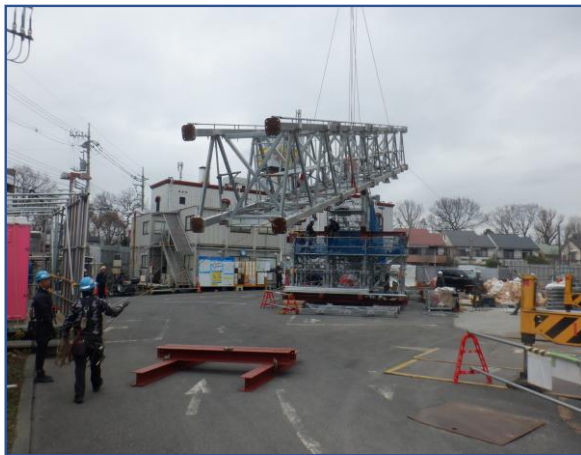
全覆い仮設テント解体
