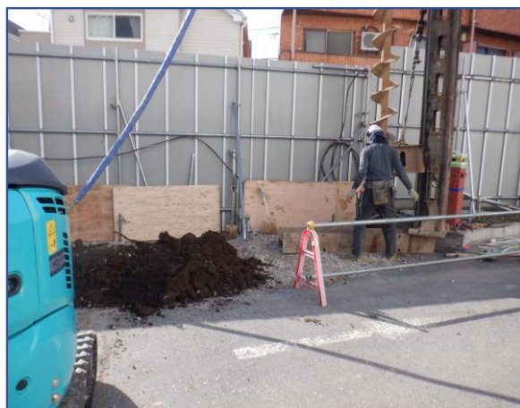
仮設防音壁設置
