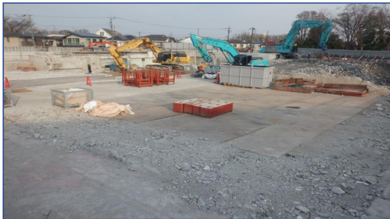
工場棟上屋解体後定点撮影(北西側)
