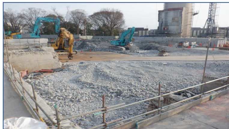
工場棟上屋解体後定点撮影(北東側)
