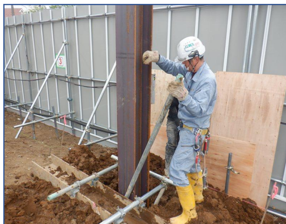
仮設防音壁設置
