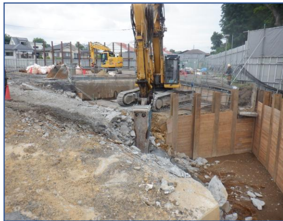
旧煙突基礎解体
