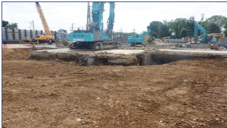
工場棟上屋解体後定点撮影(北西側)
