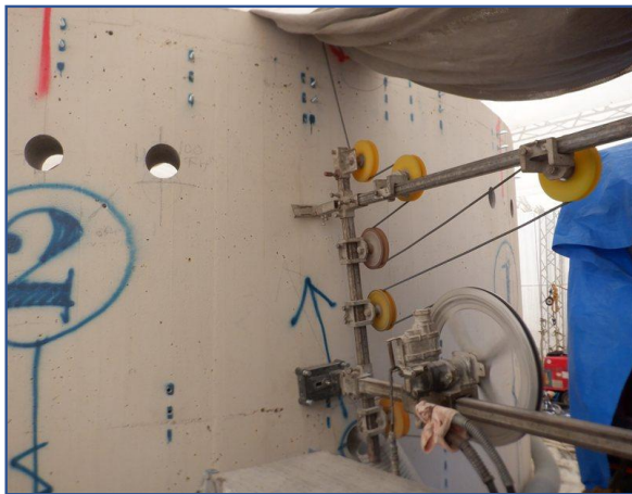
煙突外筒解体
