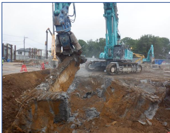
工場棟基礎解体
