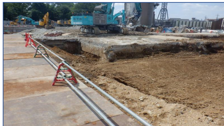
工場棟上屋解体後定点撮影(北東側)
