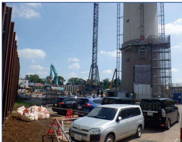
敷地内定点撮影(南西側)
