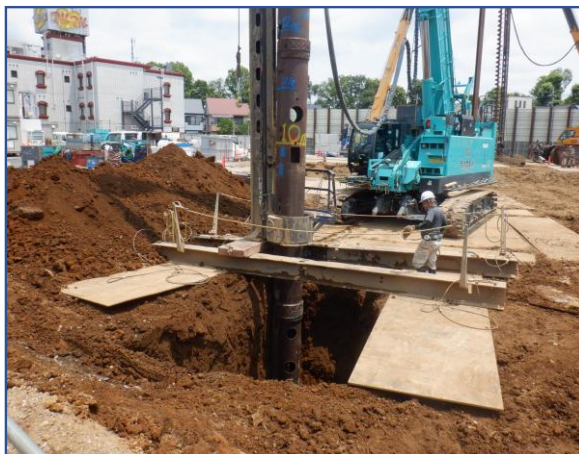
工場棟杭抜き
