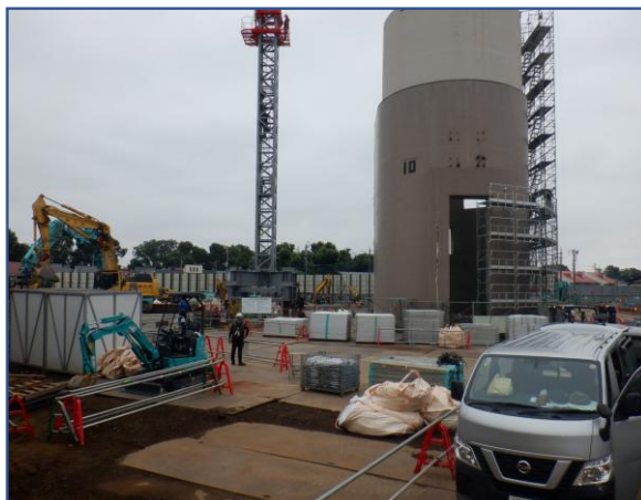
敷地内定点撮影(南西側)
