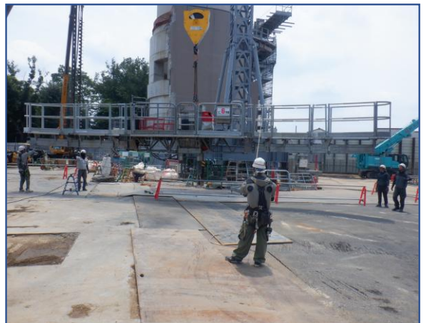
スカンクライマー解体
