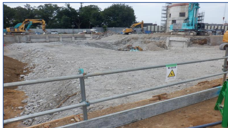
工場棟上屋解体後定点撮影(北東側)
