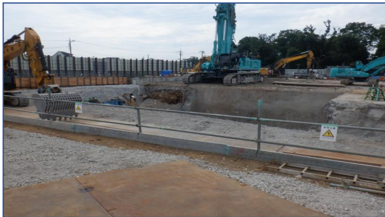
工場棟上屋解体後定点撮影(北西側)
