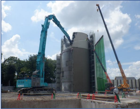
煙突外筒解体
