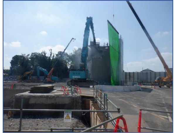
煙突外筒解体
