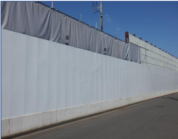
定点撮影(南側)
