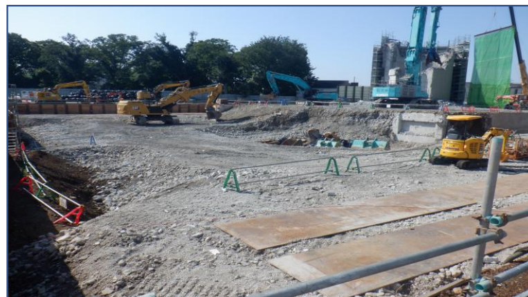
工場棟上屋解体後定点撮影(北東側)
