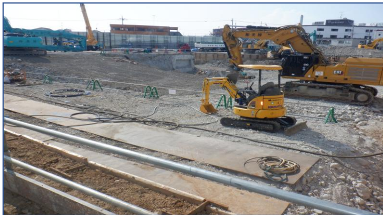
工場棟上屋解体後定点撮影(南東側)
